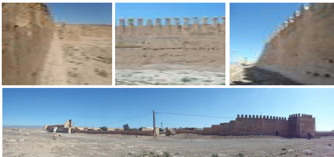
Rempart construit en gradins, faisant réduire l'épaisseur du rempart depuis la base jusqu'au chemin de ronde.
