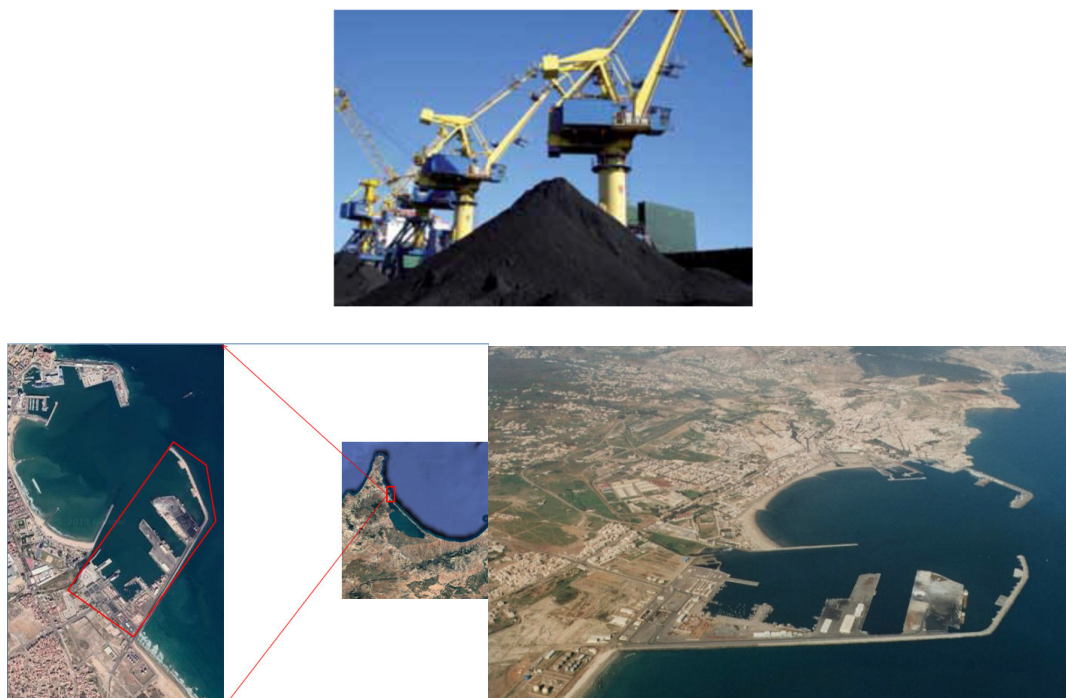
Figure 29. Port de Nador. Quai charbonnier.
